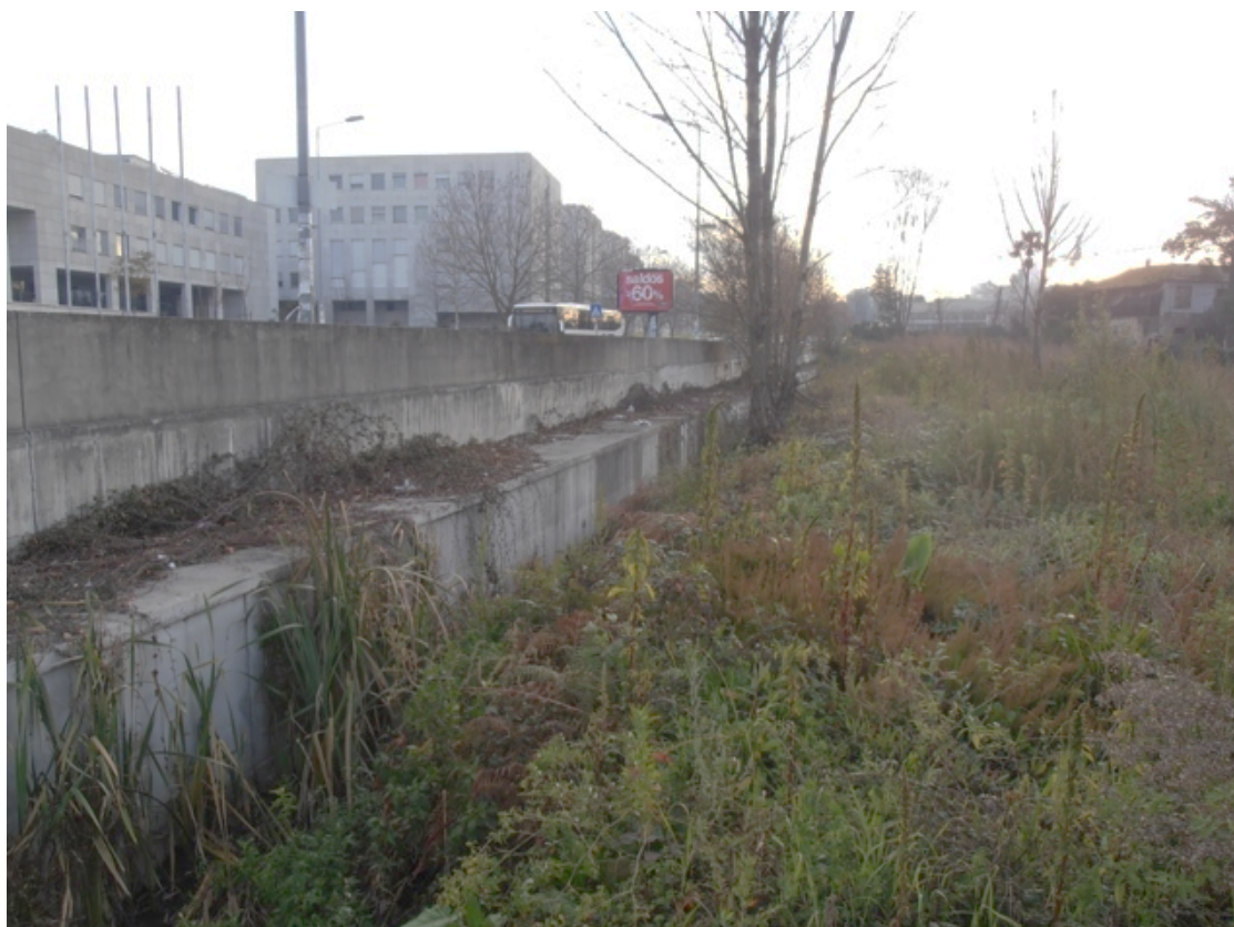
Fig. 7 – Ribeira da Asprela, situação existente.
