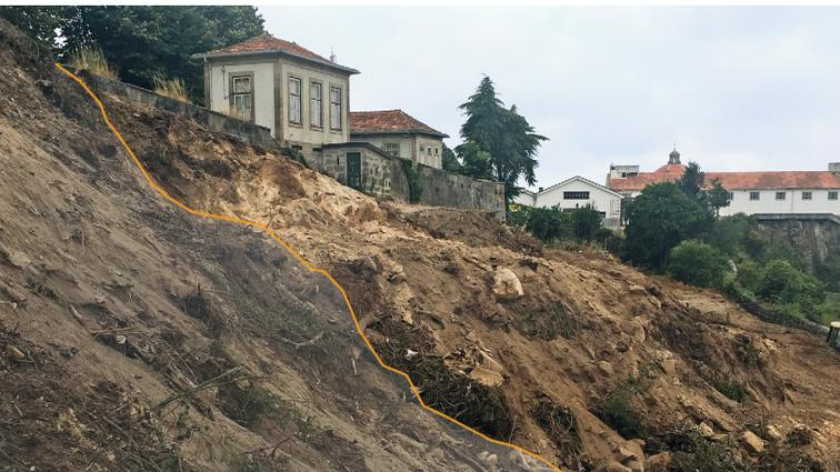
Talude com inclinação excessiva. Graves problemas de erosão e degradação geral.
