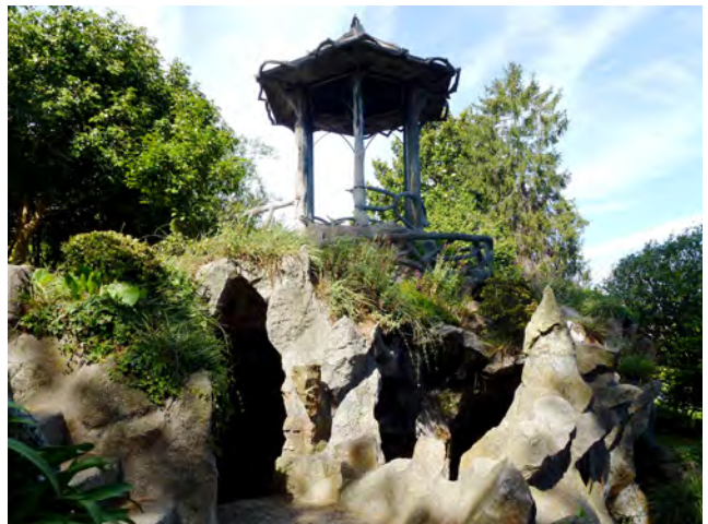
Fig. 103: Mirante em betão armado sobre a gruta.
