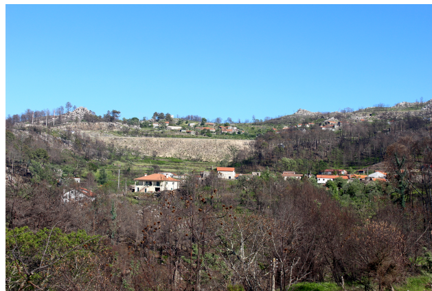
Figura 4.10: Lugar de Covelo atravessado pela A25 e pelo IP5 Fonte: Autor
