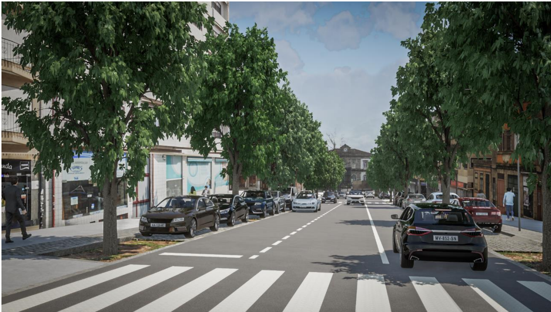
Figura 11.8 - Vista a partir do eixo da rua: espaço viário com três vias de trânsito (dois sentidos) e zona de estacionamento que tira partido do espaço da arborização; espaço da arborização com alinhamentos laterais de árvores de copa média-larga em caldeira; espaço pedonal com bandas de pavimento rugoso e liso (circulação universal).
